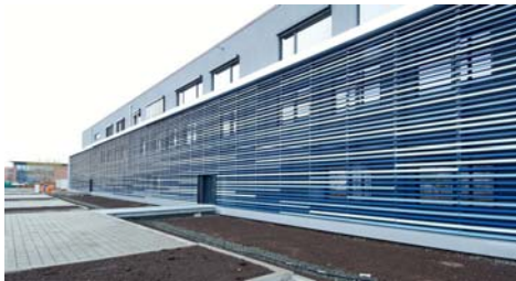
Neubau Kompetenzzentrum für Hochtechnologien und Solarwirtschaft, Erfurt Südost
