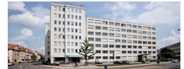
Steinplatz 1 Ehemaliger Campus der Fachrichtung Wirtschaft Former Department of Business
