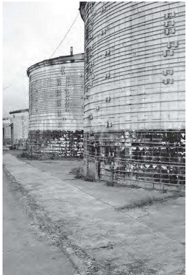
Abb. 3: Silos der Milchviehanlage in Berlstedt, 2019. Quelle: Dokumentation des studentischen Projektes an der Professur Denkmalpflege und Baugeschichte der Bauhaus-Universität Weimar 2019/20.
