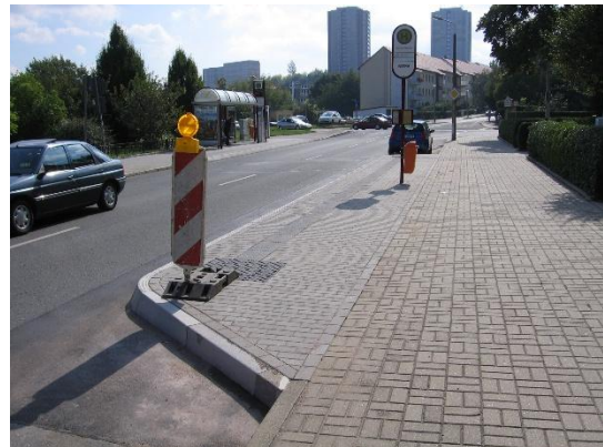
Ideale Anordnung einer Bushaltestelle hier als Kaplösung – rechts: Beispiel Erfurt, Häßlerstr. mit Kaseler Sonderbord (18 cm) zur Gewährleistung des barrierefreien Einstiegs
