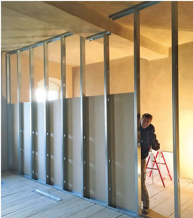
Nach der Abtrennung des Musterzimmers erfolgt der Aufbau der 2,20 Meter hohen Rückwand, die Teil des Möbels wird. • In the separated model room, the high back wall for the furniture item is constructed.
