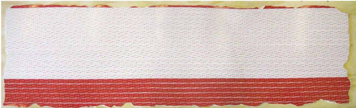
Wandmalerei „Amor & Psyche“ aus dem Dehns Palæ (19.Jh.), Kopenhagen Rückseite: nach Abnahme, Putzausdünnung und Applikation der VHB-Klebebandstreifen (Zwischenzustand Juni 2014)
