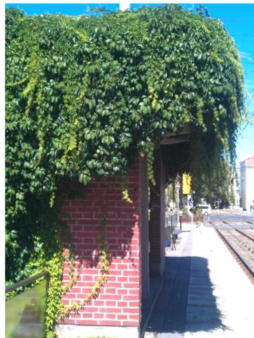
*Abbildung 3: Dreiseitig umschlossener Fahrgastunterstand mit Wänden aus Mauerwerk und Betondach an der Coventrystraße (© Umweltamt der Landeshauptstadt Dresden)*
