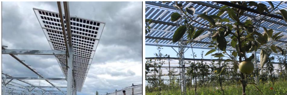
Abbildung 76: Semitransparente Glas-Glas-Module der APV-Anlage im Apfelanbau in Gelsdorf (Hopf, Fraunhofer ISE, 2021).
