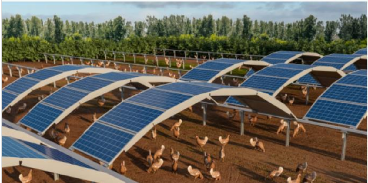
Abbildung 29: Solarbogen "Modular Arc System" der Firma GoldbeckSolar mit Tierhaltung (Goldbeck, o.J.).
