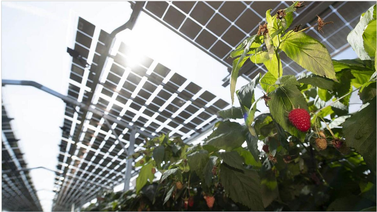
Abbildung 30: Semitransparente Module, hier als Überdachung für Himbeeren, Niederlande (BayWa r.e., 2021).
