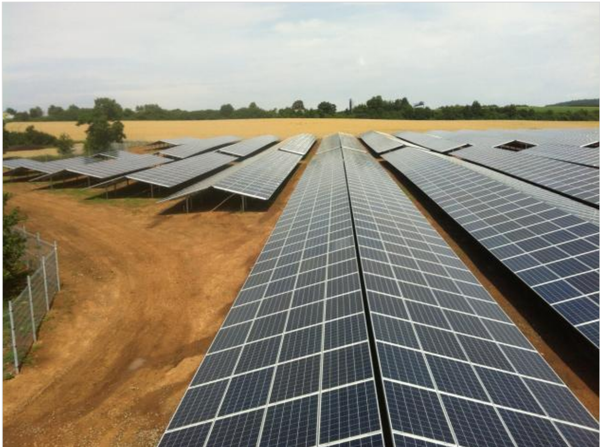
Abbildung 27: Darstellung Dome-Struktur Ost-West-Ausrichtung der Freiflächenanlage in Hölzengraben, Kaiserslautern (IBC Solar, 2013).
