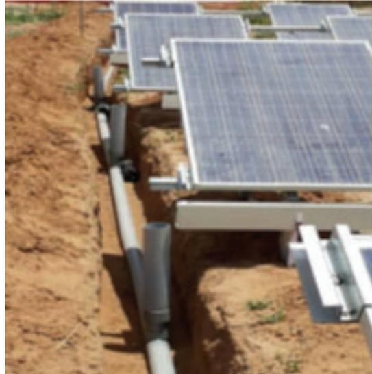
Abbildung 45: Bau der Verrohrung in einer bodennahen APV-Anlage in Indien (Santra et al., 2018).
