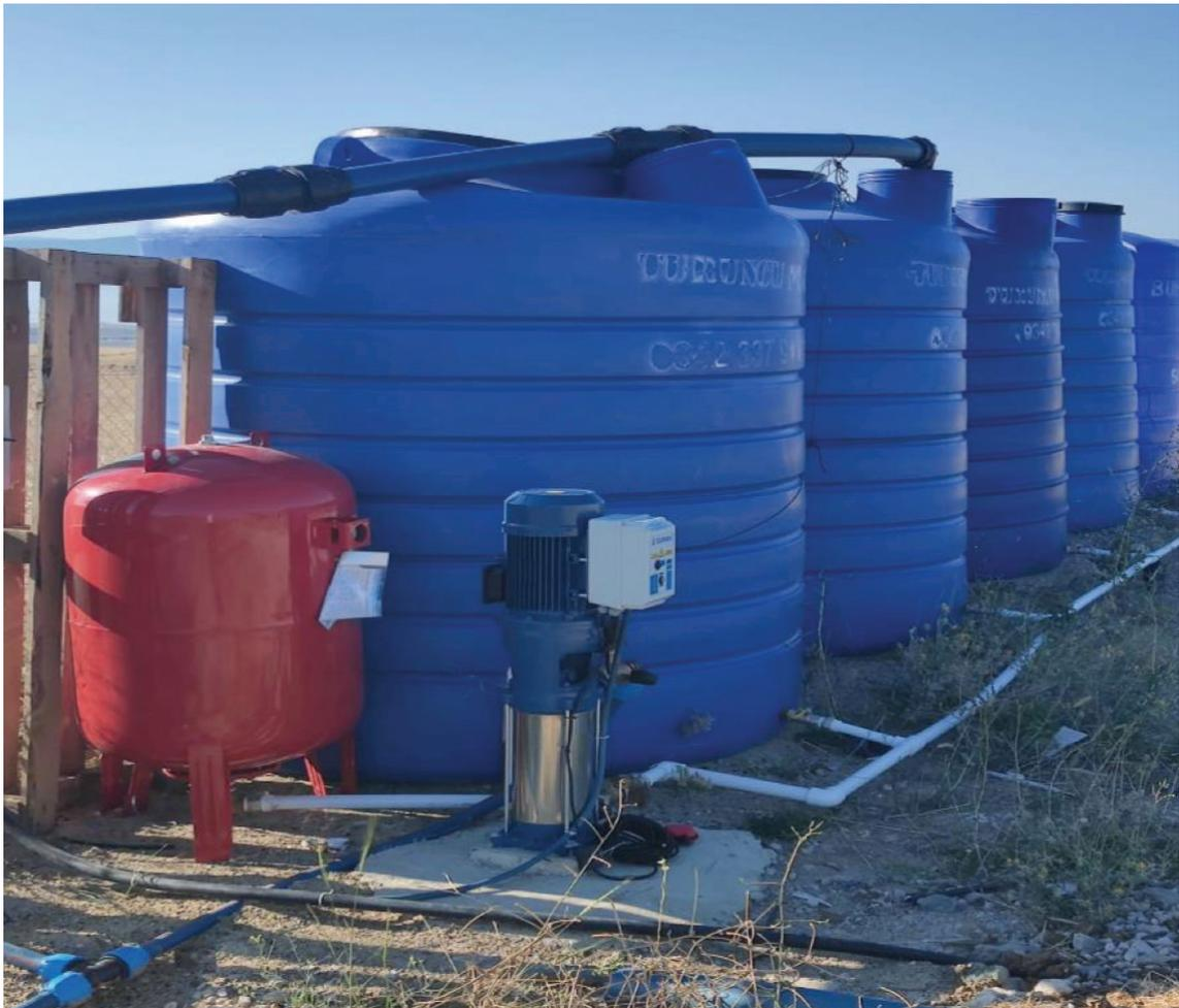
Abbildung 51: Speichertanks für das aufgefangene Wasser in einer bodennahen PV-Anlage in der Türkei (Sevik et al., 2022).
