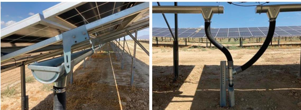
Abbildung 48: Details Rainwater-Harvesting-System in der APV-Anlage in Alhendin, Südspanien (Bousi, 2024).
