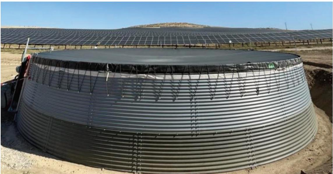
Abbildung 52: Detail Speichertank Rainwater-Harvesting-System in der APV-Anlage in Alhéndin, Südspanien (Bousi, 2024).
