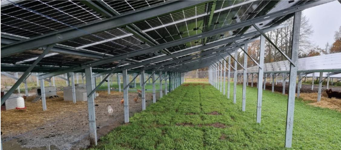
Abbildung 29: APV-Anlage der Firma SUNfarming GmbH mit wasserverteilender Unterkonstruktion (sunfarming.de).
