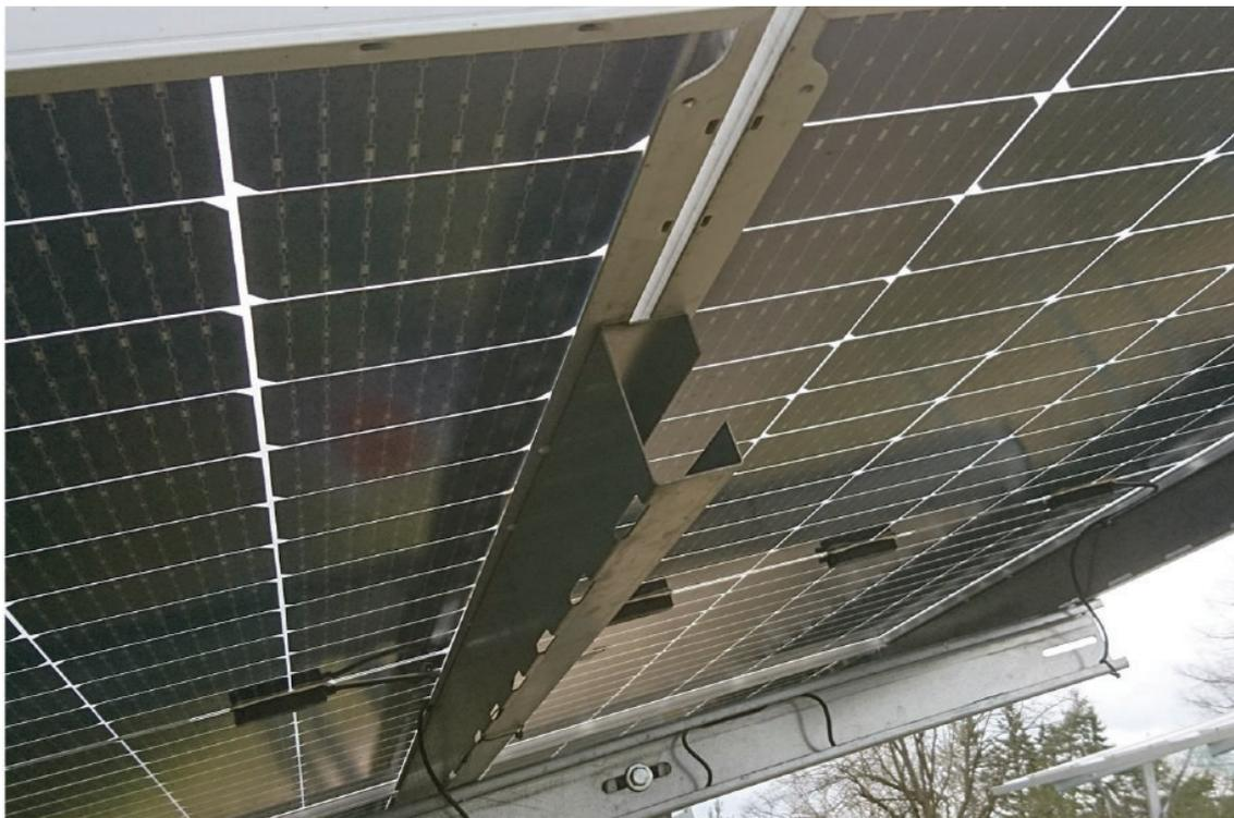
Abbildung 30: Detail der wasserverteilenden Unterkonstruktion der Firma SUNfarming GmbH (sunfarming.de).
