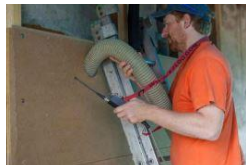
Abbildung 36 Einblasdämmung wird per schlauch in eine Wand geblasen.
