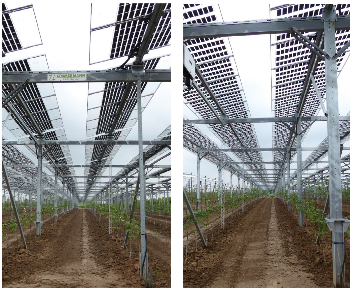
Abbildung 11: Agri-PV-Anlage mit Modultypen „Block“ (links) und „Zebra“ (rechts), sowie nachgeführter (links) und fixer (rechts) Aufständering, (Bildquelle: Fraunhofer ISE)
