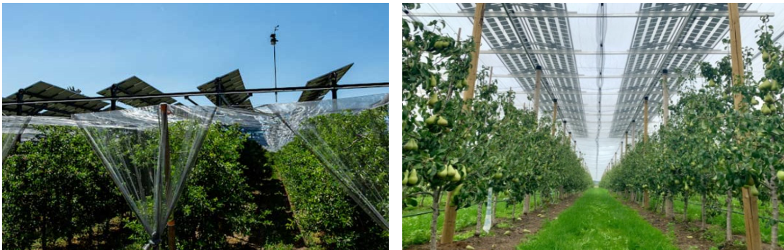
Abbildung 5: Agri-PV-Pilotanlage in Frankreich über Äpfeln (links) und in Belgien über Birnen (rechts) (Bildquellen: Sun'Agri, KU Leuven)
