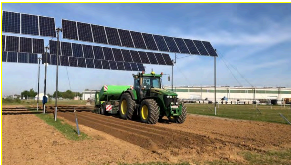
Abbildung 37: Abgespannte Seilaufhängung einer APV-Anlage in Straßkirchen, Bayern (Krinner Carport GmbH, Harlander, 2021).
