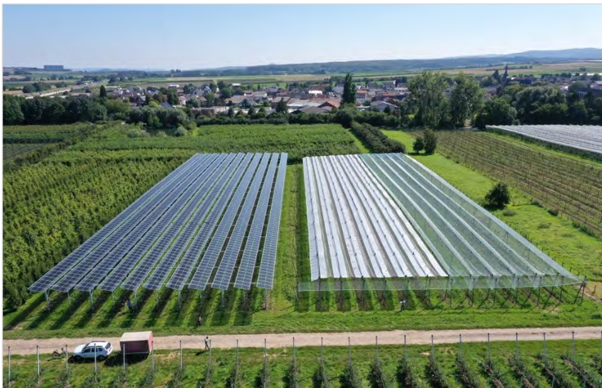
Abbildung 12: Vergleich optischer Auswirkungen auf das Landschaftsbild zwischen Hagelschutznetz (rechts), Hagelschutzfolie (Mitte) und APV-Anlage (links) (©Fraunhofer ISE 2021).
