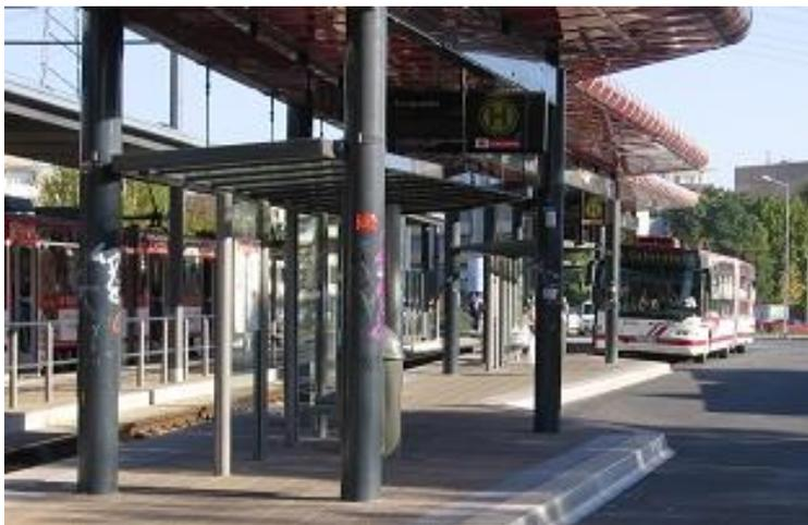
*Beispiel Erfurt, Europaplatz für einen kombinierten Verknüpfungs- und Endpunkt, Überholmöglichkeit der Busse wird durch die sägezahnförmige Anordnung der Haltepunkte gewährleistet*
