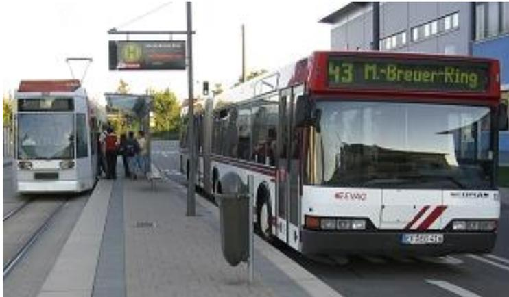
*Beispiel Erfurt, Marcel-Breuer-Ring für einen Verknüpfungspunkt zwischen Bus und Bahn, das Tür-an-Tür-Prinzip wird durch den Linksverkehr des Busses umgesetzt*
