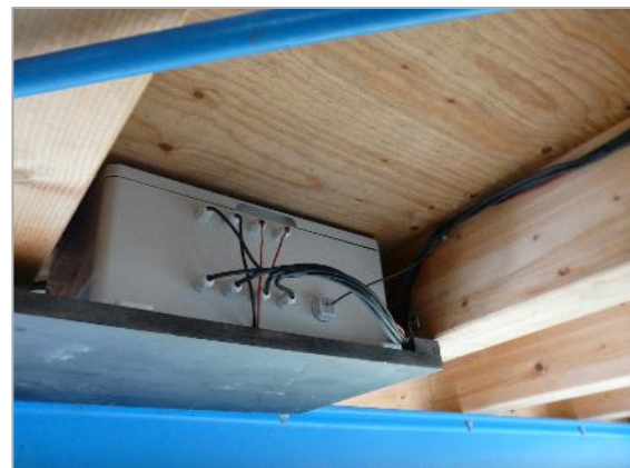
Installationskasten verschlossen
