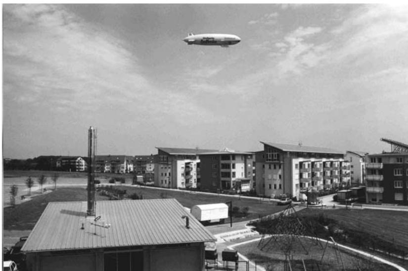
plant. Im Zuge des 1. BA wurden vier Wohnblocks mit insgesamt 280 Wohnungen erstellt. Die Wärmedämmung dieser Gebäude ist so ausgeführt, dass die Grenzwerte der WSchVO 95 um ca. 20 % unterschritten werden. Im 1. BA wurden Kollektoren mit einer Gesamtfläche von 2.700 m<sup>2</sup> installiert. Die Kollektorfläche soll im 2. BA auf insgesamt 5.600 m<sup>2</sup> aufgestockt werden; der 3. BA erhält keine Kollektoren. Mit der Solaranlage sollen etwa 48% (1.920 MWh) des Ge-
