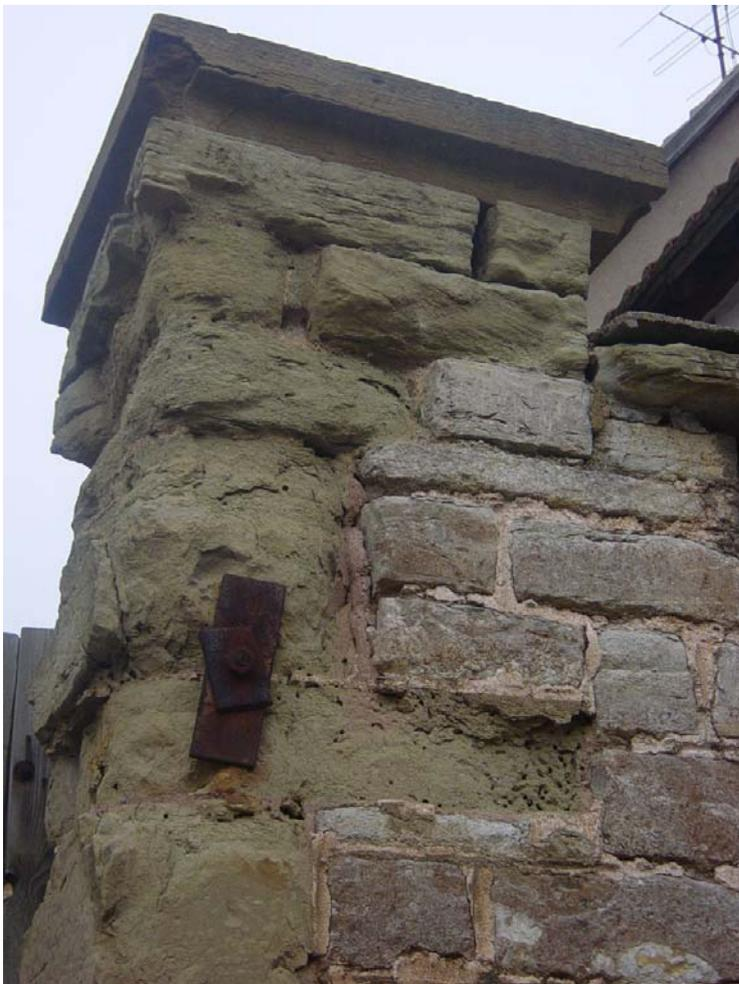
Abb. 2: Absandungen am Keuper-sandstein eines Torpfeilers
