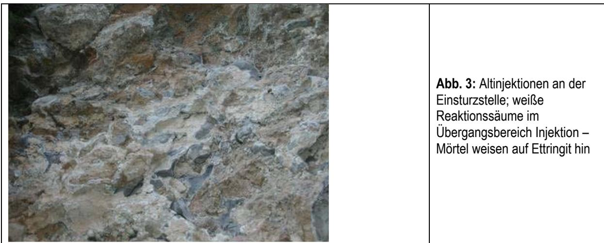
**Abb. 3:** Altinjektionen an der Einsturzstelle; weiße Reaktionssäume im Übergangsbereich Injektion – Mörtel weisen auf Ettringit hin
